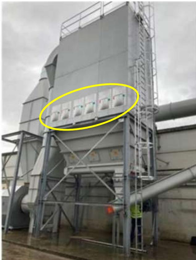
Les trappes soufflables - localisées par un cercle jaune sur la photo ci-contre - ne sont pas placées face à un bâtiment et il n'y a aucun équipement à hauteur d'homme en façades extérieures et en parois intérieures des bâtiments.
